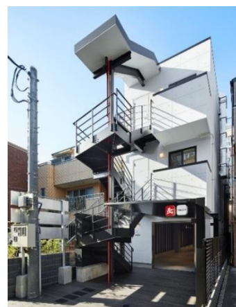
▲「クラウドキッチン」施設外観
